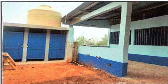
MODULO IV. Se puede observar en la imagen la culminacion de la construccion de los tres baños lavables con fosa septica y con deposito de agua ROTOPLAS.
