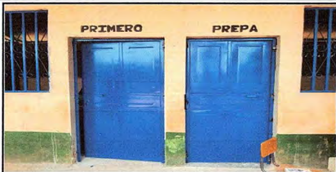
MODULO I. Se observa en la imagen la instalacion de las puertas de metal a color nacional.
