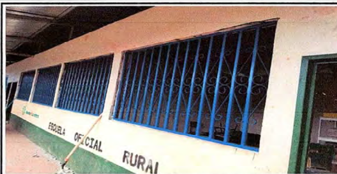
MODULO I. Instalacion de los balcones de metal en todas las aulas del edificio escolar.
