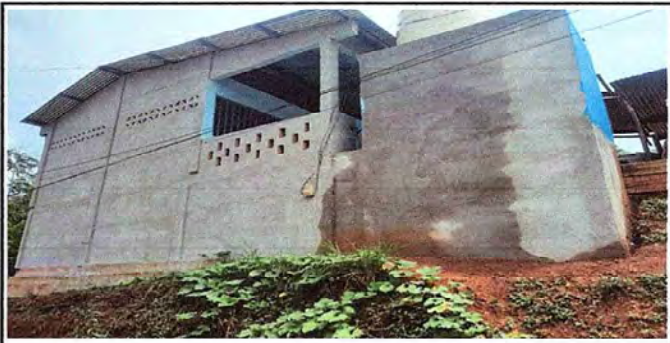
MODULO III. Se puede observar la culminacion del repello en todo el edificio escolar.
