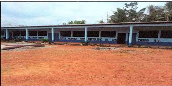
MODULO V. Se puede apreciar de como quedo el edificio escolar cambiando a color a nacional con su respectiva rotulacion.
