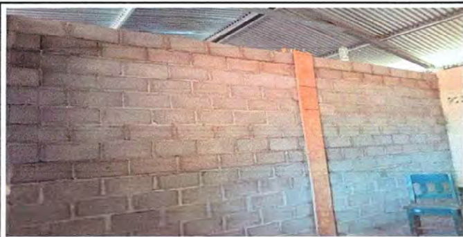
MODULO II. Se puede observar la culminacion del levantamiento de las dos paredes en dos aulas.
